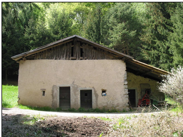
(Edificio rilev. alla scheda n. 27 – loc. Danzolino) Edificio dove si può notare la semplicità delle mantovane, il limitato sviluppo delle gronde e l'assenza di grondaie e pluviali.
