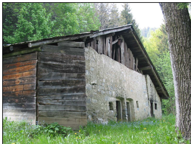
(Edificio rilevato alla scheda n. 78 – loc. Vanecle) Edificio con il colmo della copertura sul fronte principale sostenuto da una struttura lignea non equiparabile ad una capriata
