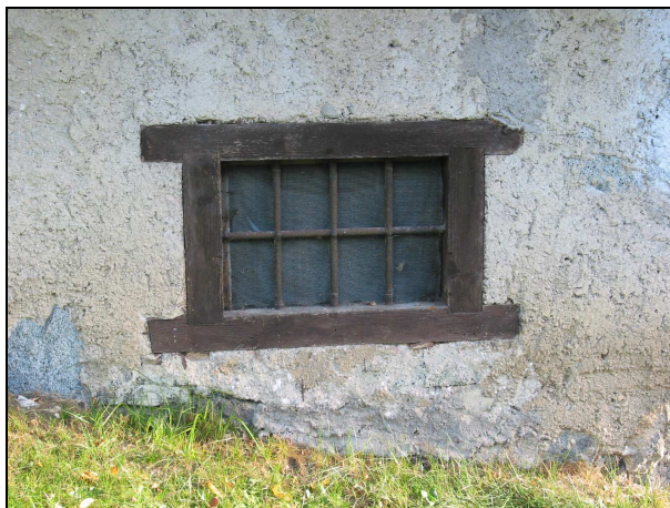
(Edificio rilevato alla scheda n. 25 – loc. Dasta) Particolare inferriata montata su stipiti in legno
