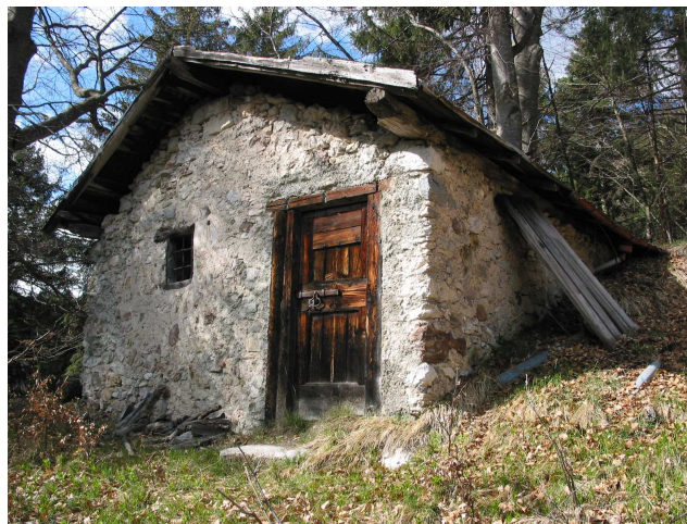
(Edificio rilevato alla scheda n. 10 – loc. Maima) Le diverse pietre reperite in loco e la loro dimensione variabile costituiscono il carattere peculiare dei paramenti murari storici
