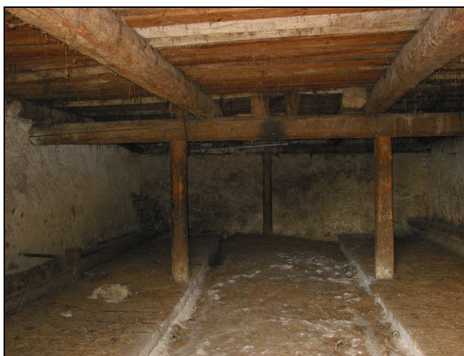
(Edificio rilevato alla scheda n. 8 – loc. Maima) Esempio di solaio in legno
