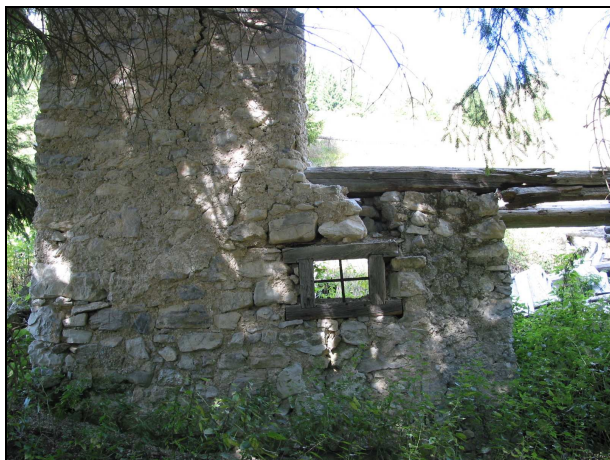
(Edificio rilevato alla scheda n. 1 – loc. Maima) Particolare finestra con contorni in legno
