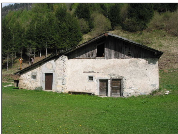
(Edificio rilevato alla scheda n. 44 – loc. Cherio) Edificio con il colmo della copertura sul fronte principale sostenuto da una capriata
