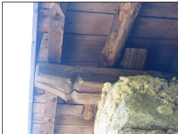
(Edificio rilev. alla scheda n. 27 – loc. Danzolino) Particolare della testa della trave della banchina del tetto.
