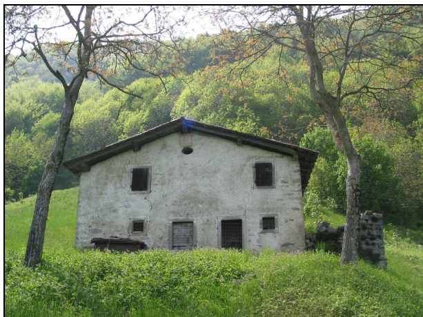
(Edificio rilevato alla scheda n. 73 – loc. Vanecle) Edificio con il colmo della copertura sul fronte principale sostenuto da un timpano in muratura
