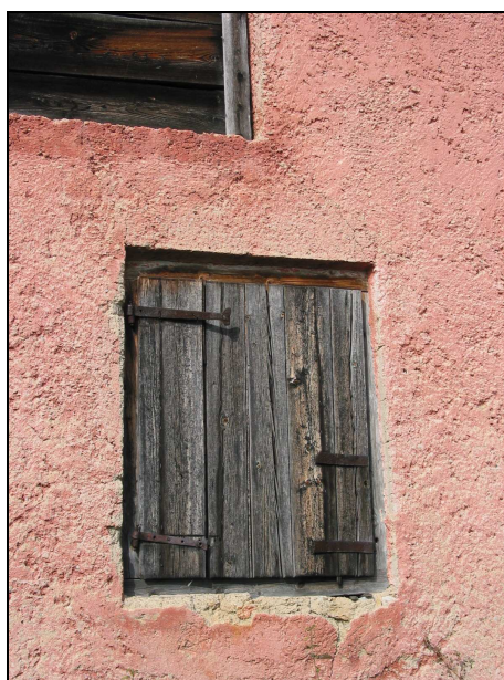
(Edificio rilevato alla scheda n. 8 – loc. Maima) Particolare ante d'oscuro in legno
