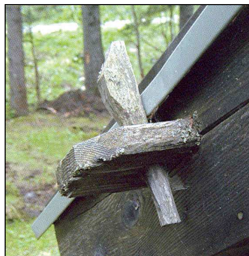
Particolare di un chiodo in legno di sostegno della mantovana
