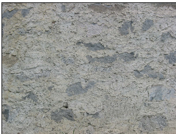
Esempio di intonaco raso sasso
