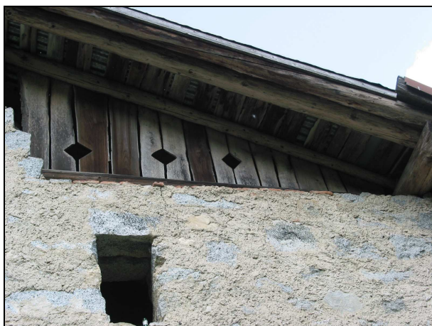
(Edificio rilevato alla scheda n. 32 – loc. Dasta) Particolare del tamponamento ligneo.
