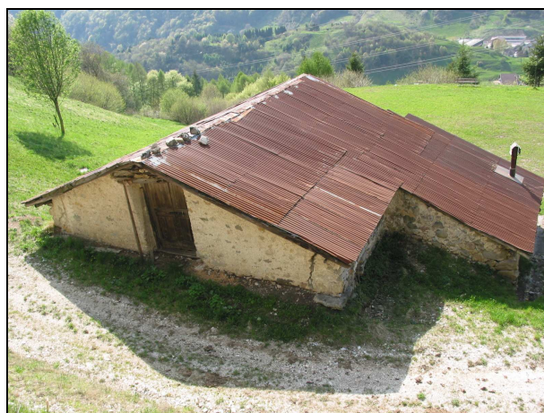
(Edificio rilevato alla scheda n. 44 – loc. Cherio) Edificio con il colmo della copertura sul retro sostenuto da un timpano in muratura
