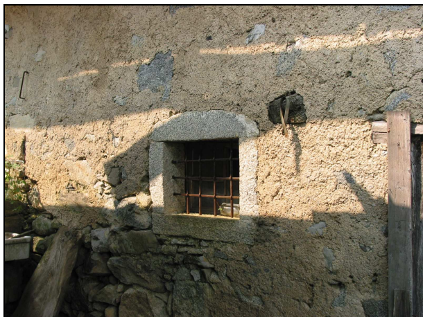
(Edificio rilevato alla scheda n. 69 – loc. Vanecle) Particolare inferriata montata su stipiti in pietra
