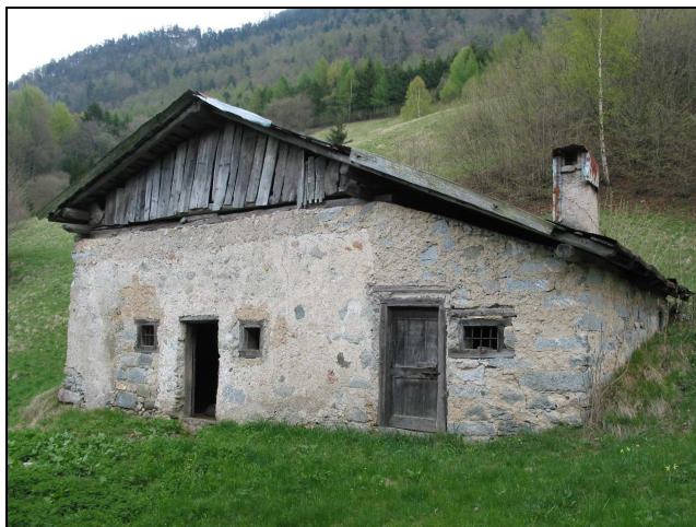
(Edificio rilevato alla scheda n. 43 – loc. Cherio) Le diverse pietre reperite in loco e la loro dimensione variabile costituiscono il carattere peculiare dei paramenti murari storici
