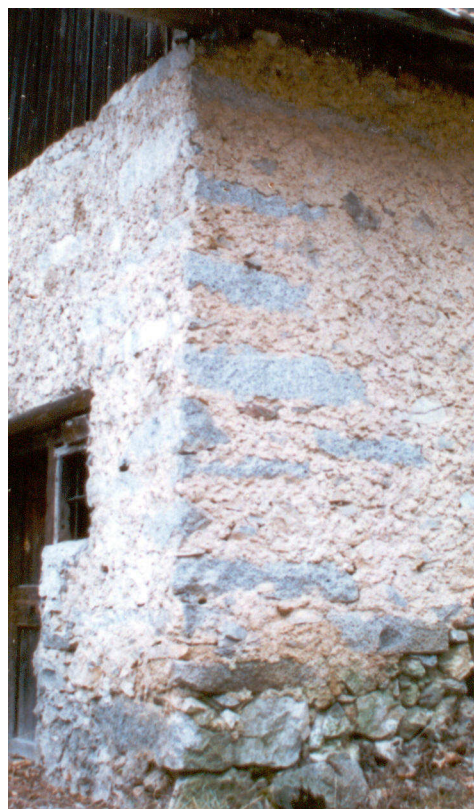
Particolare intonaco «raso sasso»
