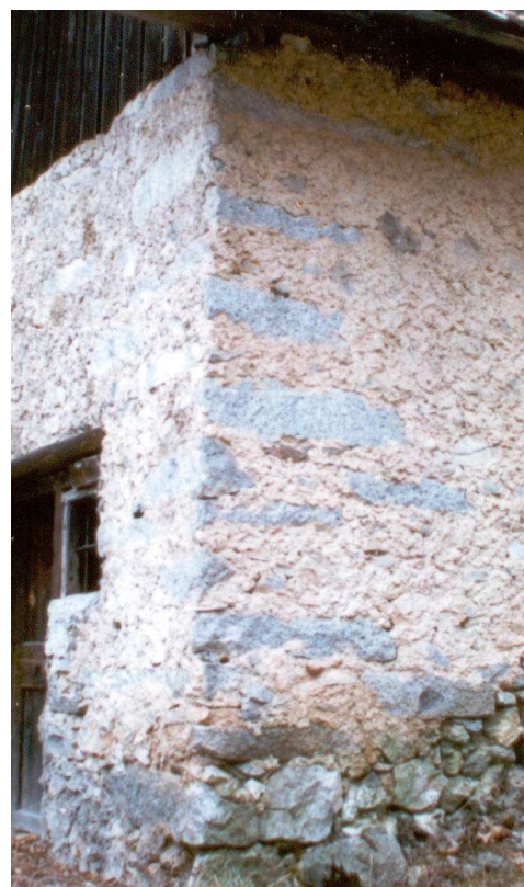
Edifici Sparsi - U.E. n. 21 particolare intonaco raso sasso
