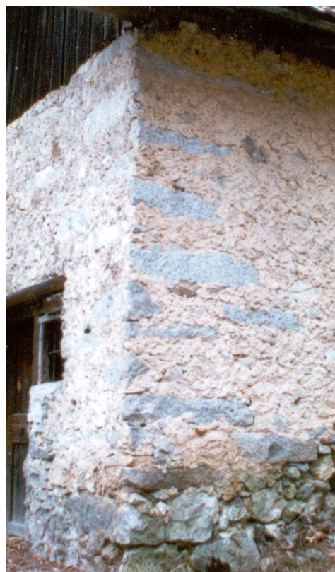
Particolare intonaco «raso sasso»
